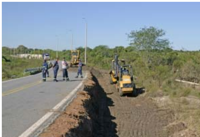
Ruta 21 - Puente El Pelado
